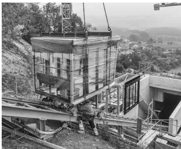
Montage der Aufzugskabine im Oktober 2025. Im Hintergrund sichtbar ist die Tunnelmündung der teilunterirdischen Schrägaufzugsanlage. Foto: Daniel Suppe, Stiftung Leuchtenburg.
