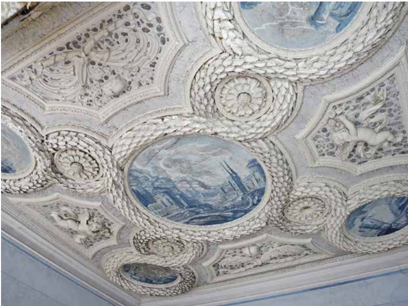
Freigelegte Zimmerdecke im Schlafzimmer des Herzogs Friedrich I. von Sachsen Gotha Altenburg, dem Erbauer des Schlosses, der in diesem Raum am 2. August 1691 im Alter von 45 Jahren starb, Foto: Jörg Möller.
