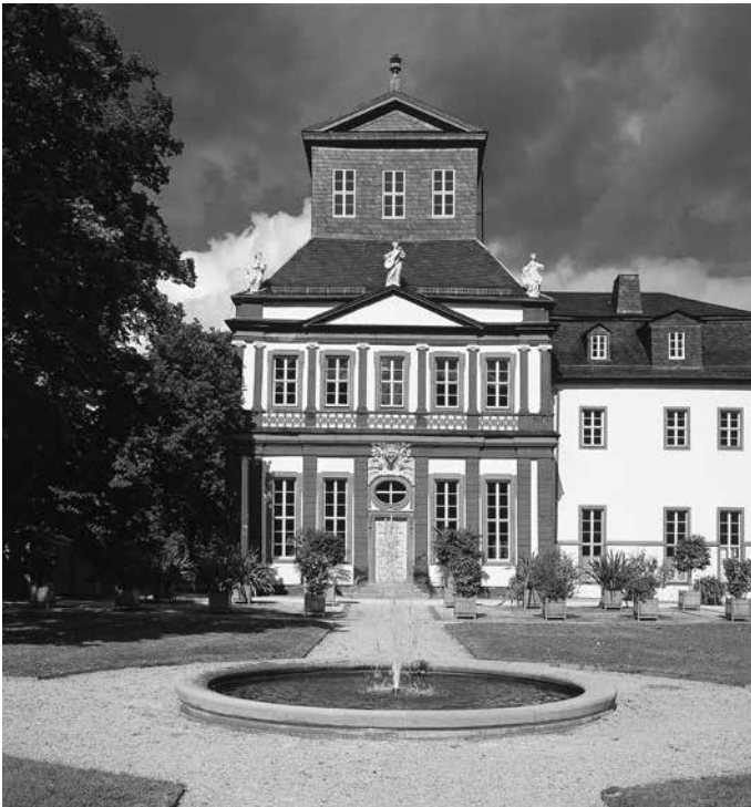
Schloss Schwarzburg, Kaisersaalgebäude mit Orangerieparterre, Quelle: Stiftung Thüringer Schlösser und Gärten, Foto: Constantin Beyer.
